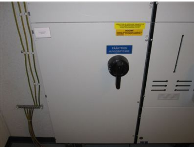
Pääkytkin sähköpääkeskuksessa
