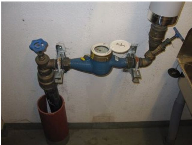
Päävesimittari ja veden sulkuventtiilit
