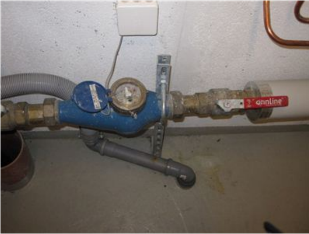
Päävesimittari ja veden sulkuventtiilit
