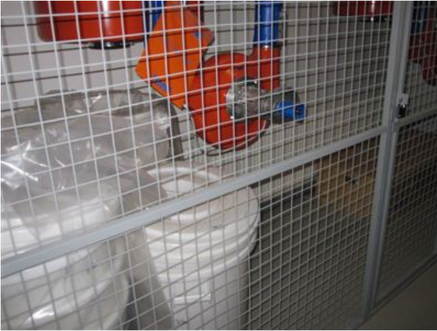
Väestönsuojan suojapuhallin ja turvallisuustarvikkeita
